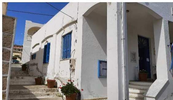
Εικόνα 3: Η νότια όψη και μέρος της ανατολικής όψης του κτηρίου.
