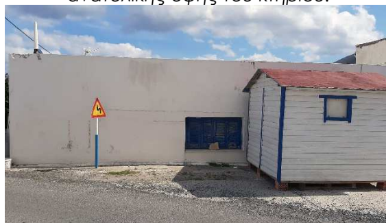
Εικόνα 5: Η δυτική όψη του κτηρίου.
