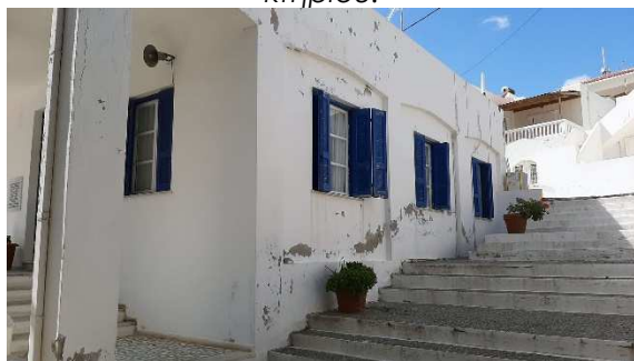
Εικόνα 4: Η βόρεια όψη του κτηρίου.
