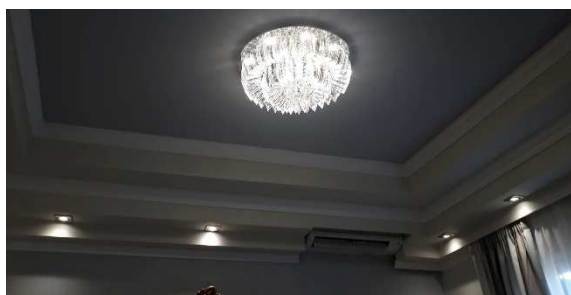
Εικόνα 8α: Φωτιστικά LED στο γραφείο Δημάρχου.
