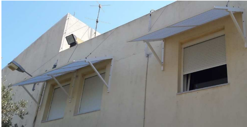
Εικόνα 6: Προτεινόμενη κατασκευαστική λύση για τους οριζόντιους προβόλους σκίασης.
